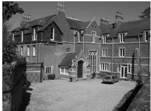
THE CHANTERS HOUSE - SY09 NE 1/4
